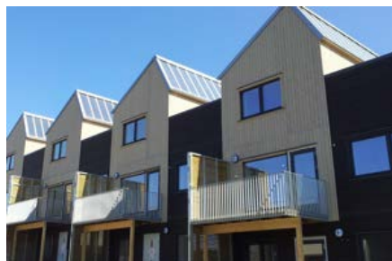
Solfangere i takoppbygg, OBOS, Stenbråtlia utenfor Oslo
