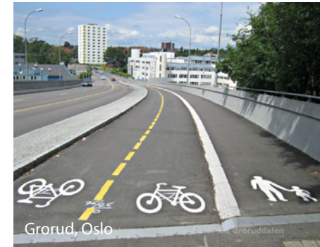
Eksempel på sykkelvei med fortau og piktogrammer i asfalten.
