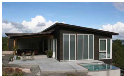
Eneboligen i Stavem med fasademonterte solfangere fra NorDan Solar. Systemet består av Aventa-solfangere integrert i NorDans vinduskarmer, og monteres i fasade på samme måte som et vanlig vindu. Bak solfangeren lektes og isoleres veggene som vanlig.
