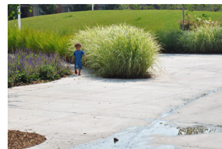
Eksempel på vannrenne i dekke.
