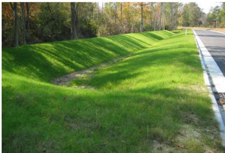
Figur 2-2. Eksempel på gresskledd vannvei. Figur hentet fra Asker kommunes veileder for overvannshåndtering.
